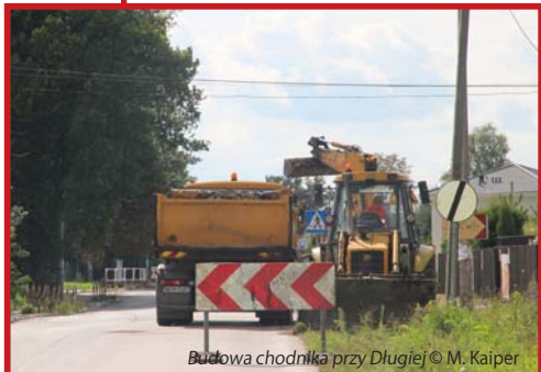
Budowa chodnika przy Długiej © M. Kaiper
