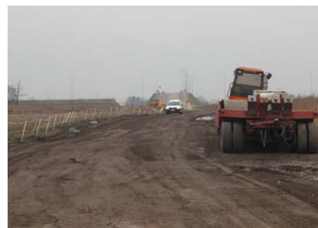
Obecnie nawierzchnia jest zupełnie dziurawa © M. Kaiper
