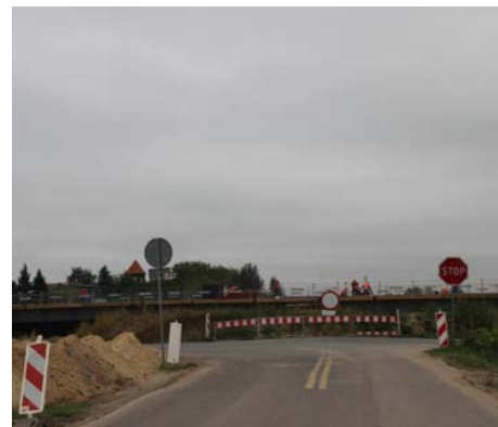
Budowa węzła Sokołowska © M. Kaiper
