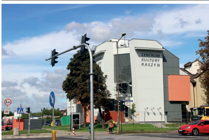
Prace wykończeniowe na zewnątrz budynku © M. Kaiper
