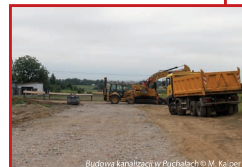
Budowa kanalizacji w Puchałach © M. Kaiper
