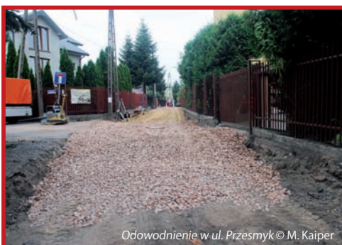
Odowodnienie w ul. Przesmyk © M. Kaiper
